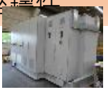
不斷電系統功率轉換系統 (KKWS/台達電)
